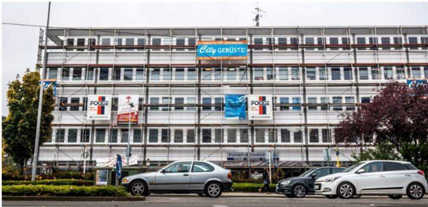
Dieses Gebäude an der Friedrichstraße 12 hat als erstes eine Fassadensanierung erfahren.
